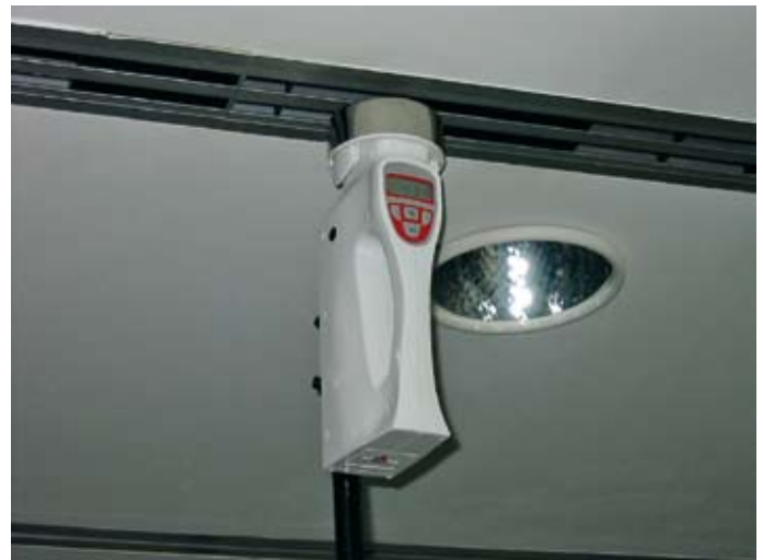
■ Bild 5: Messanordnung für die Luftkeimkonzentrationsmessung der Zuluft an einem Schlitzluftauslass.
